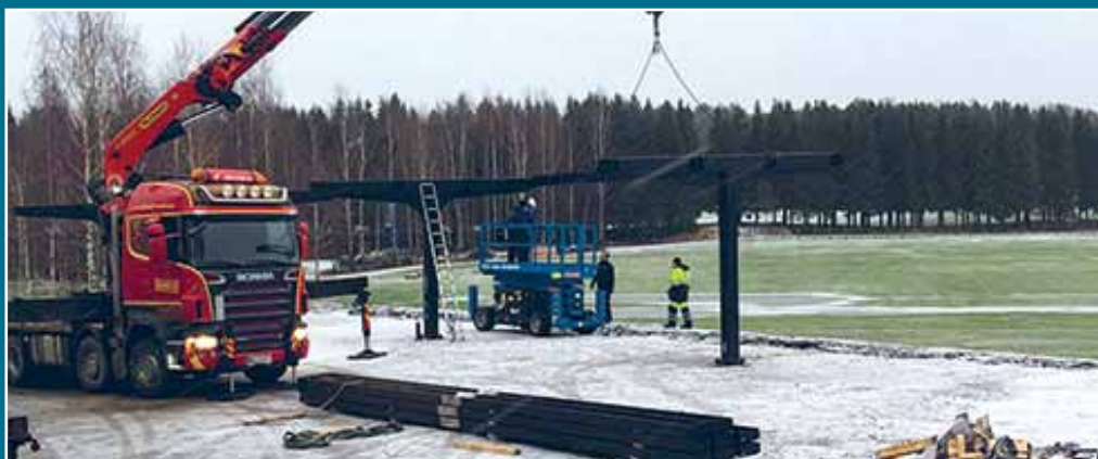
Katoksen asennus, marraskuu 2020.
